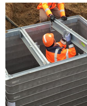
Pose / Dépose Traverses
