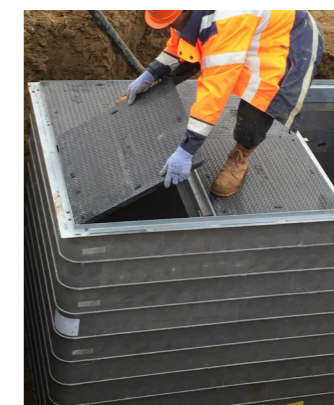
Pose / Dépose Tampons
